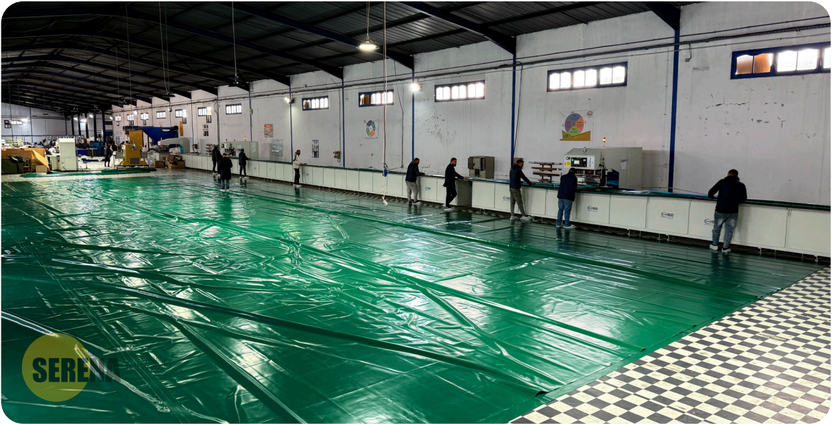
Fabrication d'une citerne de 1000 m 3
